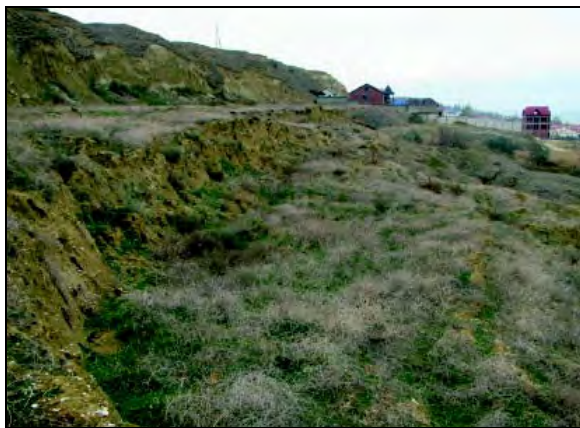
Рис.1. Оползневые смещения в районе пгт. Манас (ГУП РЦ «Дагестангеомониторинг»)
