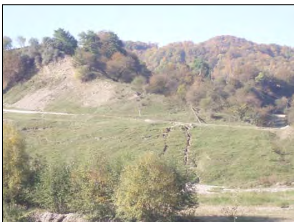
Рис.4. Активизировавшийся оползень в районе с. Чишки (ООО «СтройСервис»)
