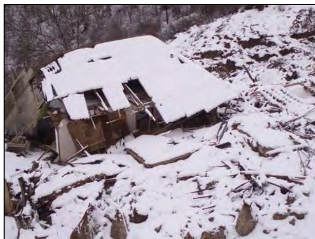
Рис.7. Разрушенный в результате активизации оползневого процесса жилой дом в с. Аллерой (ООО «СтройСервис»)
